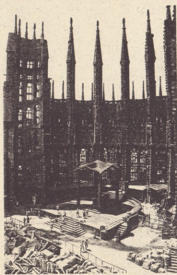
. . . wird noch gebaut
