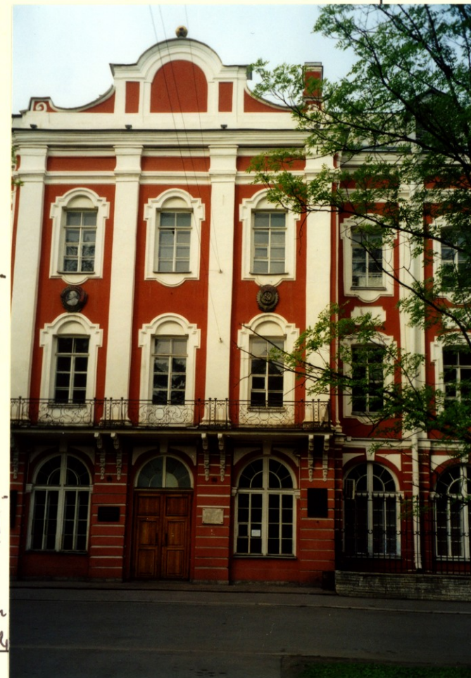
Haupteingang der Petersburg Universität
