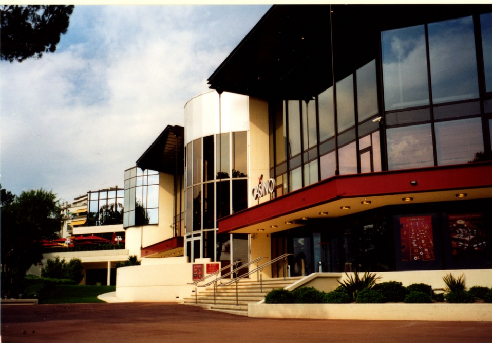
Das Casino am Seeufer
