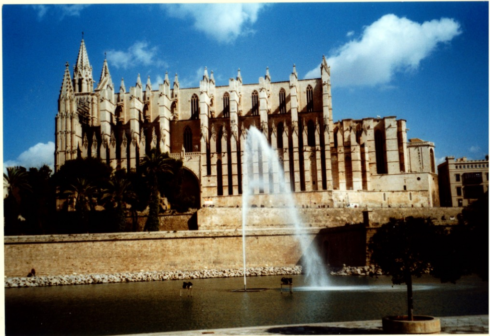
Die Kathedrale oberhalb des künstlich angelegten Sees
