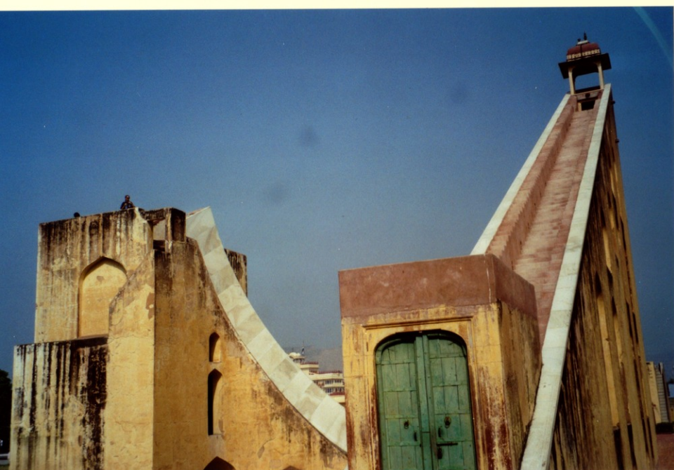
Samrat Yantra. Sein großes Samrat Yantra ist im Grunde eine einfache Sonnenuhr, mit dem Unterschied, daß sie mit ihrer Höhe von 27 m und ihrem Durchmesser von 45 m überaus groß ausgefallen ist. Wenn die Sonne über den Himmel zieht, wirft sie einen Schatten auf die an jeder Seite befindlichen, genau kalibrierten Quadranten, der sich jede Sekunde um präzise nachmeßbare 0,2 cm weiterbewegt. Neben der Ortszeitbestimmung sollte das Samrat Yantra auch zu einer höchst genauen Messung der Zenitdistanzen, der Meridiandurchgänge und der Deklinationen der Sterne dienen.
