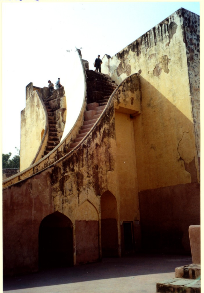
Samrat Yantra. Sein großes Samrat Yantra ist im Grunde eine einfache Sonnenuhr, mit dem Unterschied, daß sie mit ihrer Höhe von 27 m und ihrem Durchmesser von 45 m überaus groß ausgefallen ist. Wenn die Sonne über den Himmel zieht, wirft sie einen Schatten auf die an jeder Seite befindlichen, genau kalibrierten Quadranten, der sich jede Sekunde um präzise nachmeßbare 0,2 cm weiterbewegt. Neben der Ortszeitbestimmung sollte das Samrat Yantra auch zu einer höchst genauen Messung der Zenitdistanzen, der Meridiandurchgänge und der Deklinationen der Sterne dienen.
