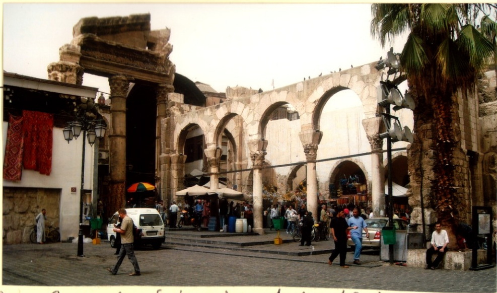
Am Ende des Sukes erhebt das Westportal des ehemaligen Jupitertempels an einer römischen Anlage
