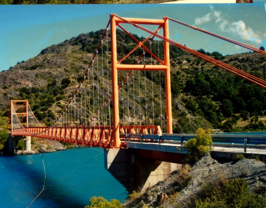
Brücke über den Rio Rosselot
